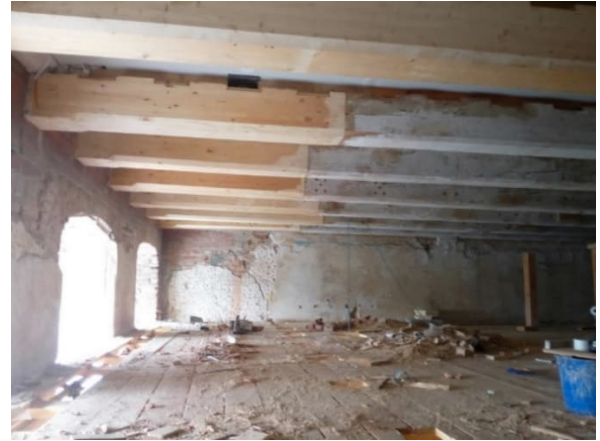
Bild 4 Balkenaufleger auf der Außenmauer nach der dauerhaften Sicherung 2024
