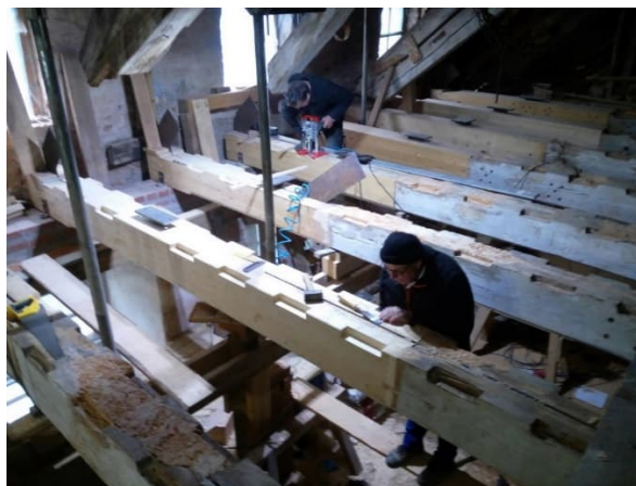
Bild 7 Ersatz der alten Balkenköpfe
