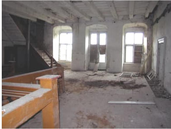
Bild 3 Blick in das Obergeschoss des Treppenhauses (Foto: U. Donau 02.06.2001)
