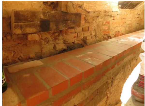
Bild 6 Neuer Ringanker aus Carbon-Mauerwerk
